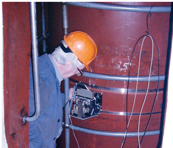
Рис. 10. Измерение уклона вала гидроагрегата на Загорской ГАЭС
