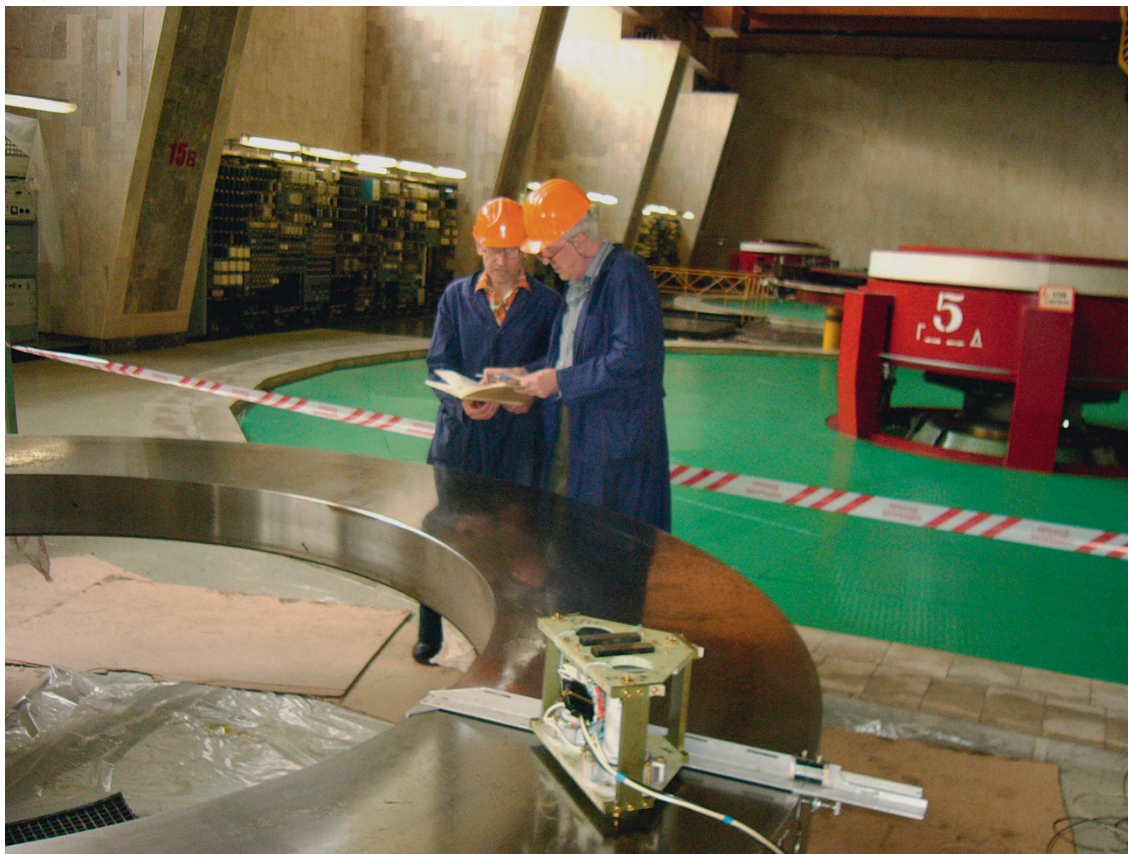
Рис. 8. Измерение волнистости и выработки диска подпятника Загорской ГАЭС при расширенном ремонте
